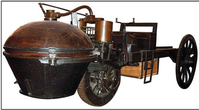
Pour améliorer le déplacement des véhicules de l'armée, Cugnot utilise la machine à vapeur : c'est le fardier de **Nicolas Joseph Cugnot** à trois roues et une chaudière à haute pression sur l'avant de la roue motrice (ci-contre). Actionnée par deux pistons, elle peut pivoter autour d'un axe vertical. Elle est prévue pour transporter 5 tonnes à 4 km/h, possède
